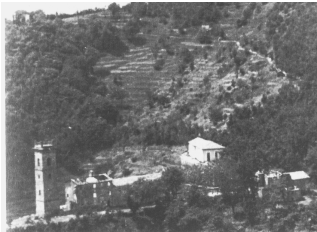
Figura 16. La zona della chiesa di Sant'Anna subito dopo la strage, vista dal lato verso Monte Lieto. Sulla destra, su piano leggermente rialzato, l'edificio della scuola (ora sede del museo). Si noti, sulla sinistra, il tetto scoperchiato dell'edificio della canonica (mentre è rimasto in piedi il forno con il camino). L'immagine rimanda ai versi di Maddalena: Poi dopo andòno in chiesa / que' diavoli feroci, / la scatenòno tutta / com' fussero tremoti . Anche gli edifici sulla piazza della chiesa furono danneggiati gravemente.
