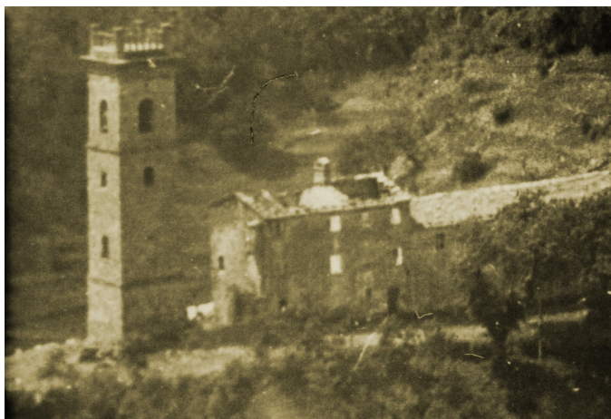
Figura 44. Veduta di Sant'Anna dopo il 12 agosto. Si noti l'assenza del tetto della canonica dovuto alle conseguenze del lancio di bombe e dell'incendio appiccato dai nazifascisti.
