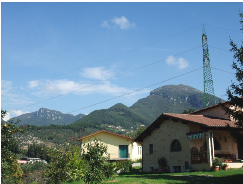
Figura 6. Il traliccio posto in prossimità della casa di Pietro, e alto 45 metri, in cui il ragazzo si arrampicava per gioco, a volte insieme col fratello e le sorelle. Sullo sfondo il monte Gabberi.
