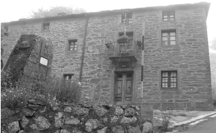
Fig. 40. Un'immagine moderna della casa in località La Madonnina di San Pellegrino in Alpe, uno dei luoghi in cui Augusto Ventura cercò inizialmente rifugio, senza successo, prima di giungere al Tendaio.
