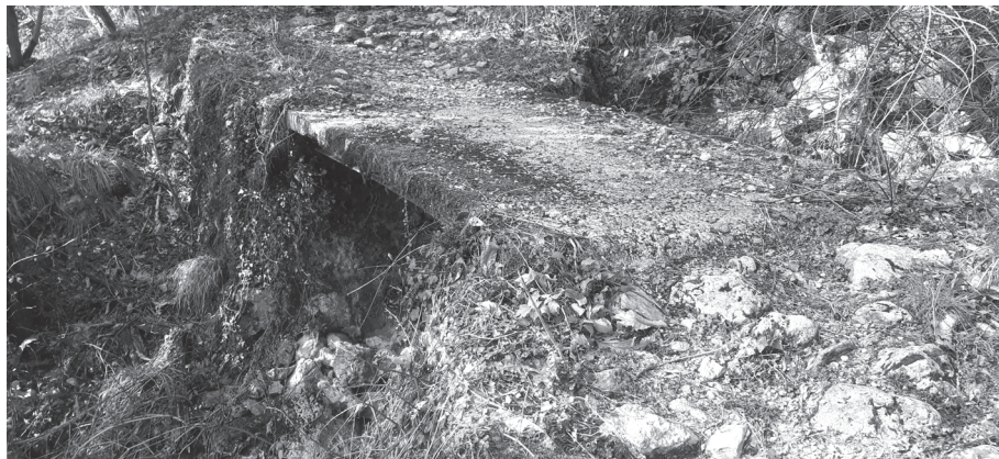
Fig. 108. Il ponte sul Rio delle Fontanacce, nell'omonima valle, alle pendici del complesso del Matanna, lungo il sentiero che porta da Casoli alla Foce del Termine. Il ruscello è quasi sempre asciutto da quando, verso la fine degli anni '40, le sue acque furono deviate per rifornire l'invaso che alimenta una centrale idroelettrica posta in Lombrici di Camaione. Il ponte è stato ricostruito dopo l'esplosione che il 9 settembre 1944 provocò la morte di Giuseppe e Giustino Pardini, e il grave ferimento di Lina Brunini.
