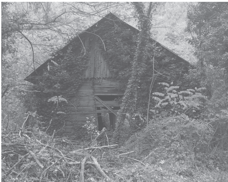
Fig. 76. I resti del padiglione in legno situato in località Candalla, a poca distanza dalla ferriera Barsi, dove i turisti diretti all’Alto Matanna venivano accolti e accompagnati, in mulo o in portantina, alla stazione di partenza del pallone. È probabile che il legno utilizzato per costruirlo fosse lo stesso impiegato per erigere l’hangar. Questo legno proveniva da una nave in disarmo che Daniele Barsi aveva acquistato a Genova.
