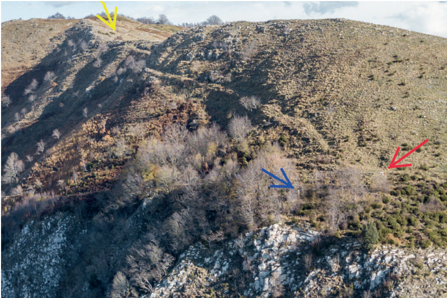
Fig. 67. Un'immagine aerea della zona in cui era situata la stazione superiore di attracco del pallone, realizzata prima che noi avessimo individuato il rudere e rimosso la boscaglia che lo occultava quasi completamente. Di questo si intravede (segnato dalla freccia blu) solo lo spigolo anteriore destro. Poco distante, sulla destra, segnato dalla freccia rossa, si intravede il bordo del piccolo terrapieno illustrato nella Fig. 66, mentre, in alto, a sinistra e in lontananza, indicata dalla freccia gialla, si intravede la piazzola di stazionamento della vettura che portava i turisti all'alto Matanna. Questa immagine rivela chiaramente il sentiero che i turisti percorrevano per raggiungere la vettura.
