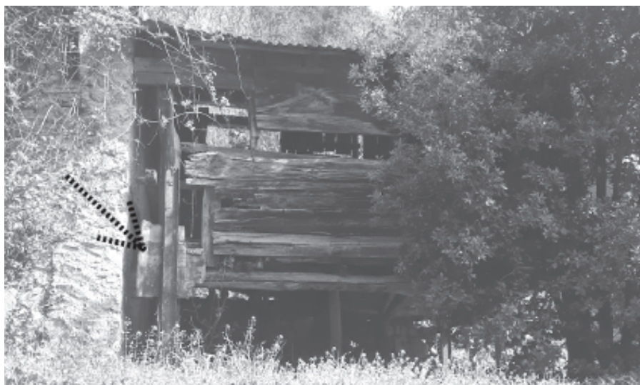
Fig. 114. La piccola costruzione in legno situata a Bollogno, nei pressi della casa di Pieraccino, che fu probabilmente costruita utilizzando i materiali dell'hangar del palone. La freccia tratteggiata sulla sinistra indica una lastra di zinco fortemente arrugginita che potrebbe essere derivata dalle lamiere usate per rivestire il tetto dell'hangar.
